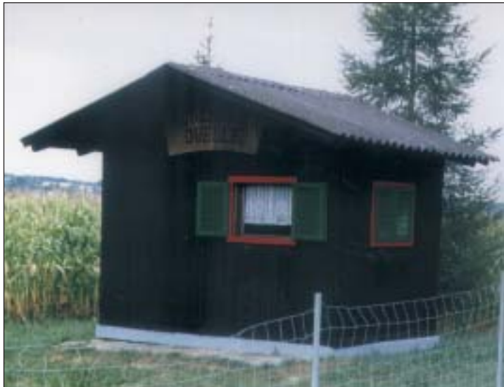
Brunnenhaus der Rosenbergquelle
