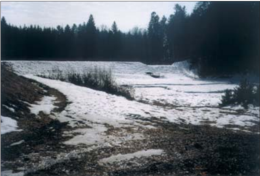
Zweites Rückhaltebecken Zehensdorf, Überlauf
